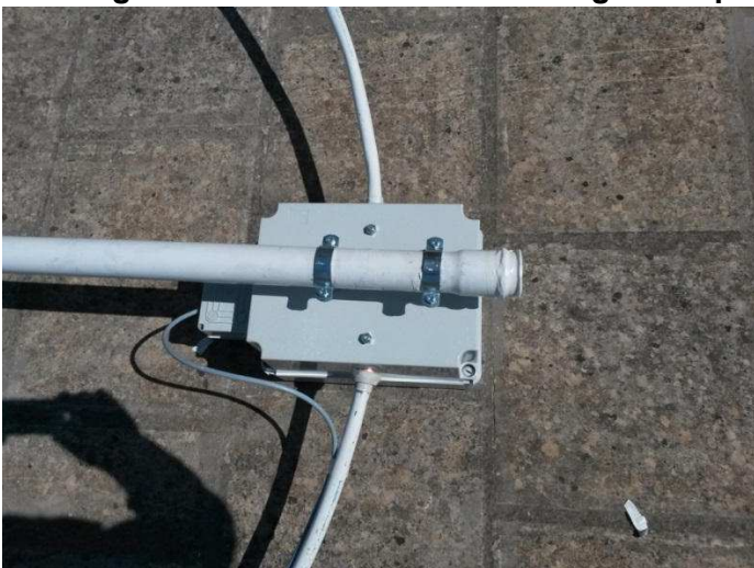
Figura 6 – particolare dell'aggancio scatola-palo di sostegno
